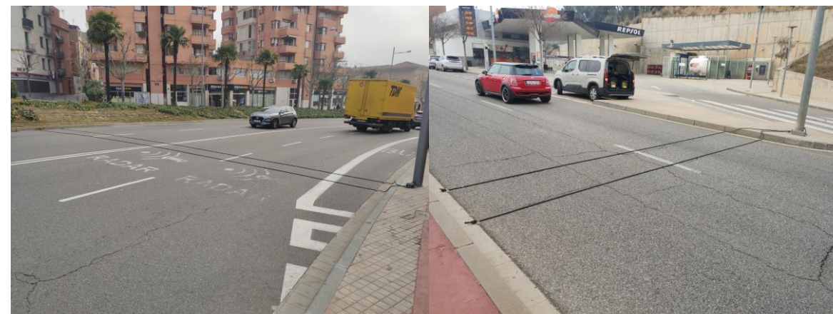
Punts d'aforament automàtic a l'Avinguda de Balmes (dreta) i la N-II (esquerra)
