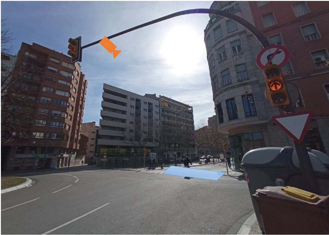
Instal·lació del conjunt càmera LPR + entorn sobre bàcul de semàfors existent, per controlar els dos carrils de circulació.
